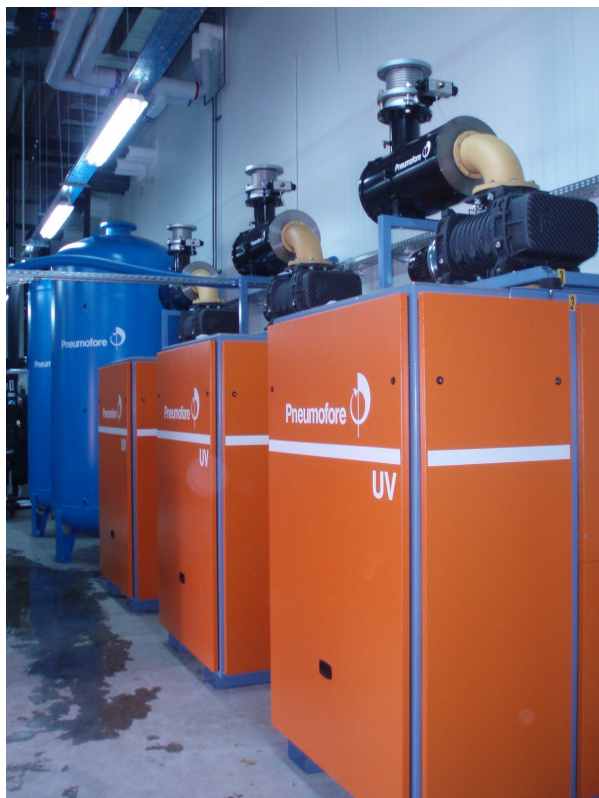
Centralvakuumanlæg til 15 linjer CFS bacon pakke maskiner hos Kreatina. De to buffertanke vidner om en central linje til Råvakuum og en til Finvakuum.
