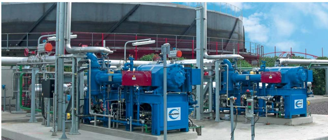
Alcuni dei compressori Mapro tipo R 300 G kW 250 installati sull'impianto di Achères (Parigi) – Il più grosso impianto anaerobico costruito in Europa.
